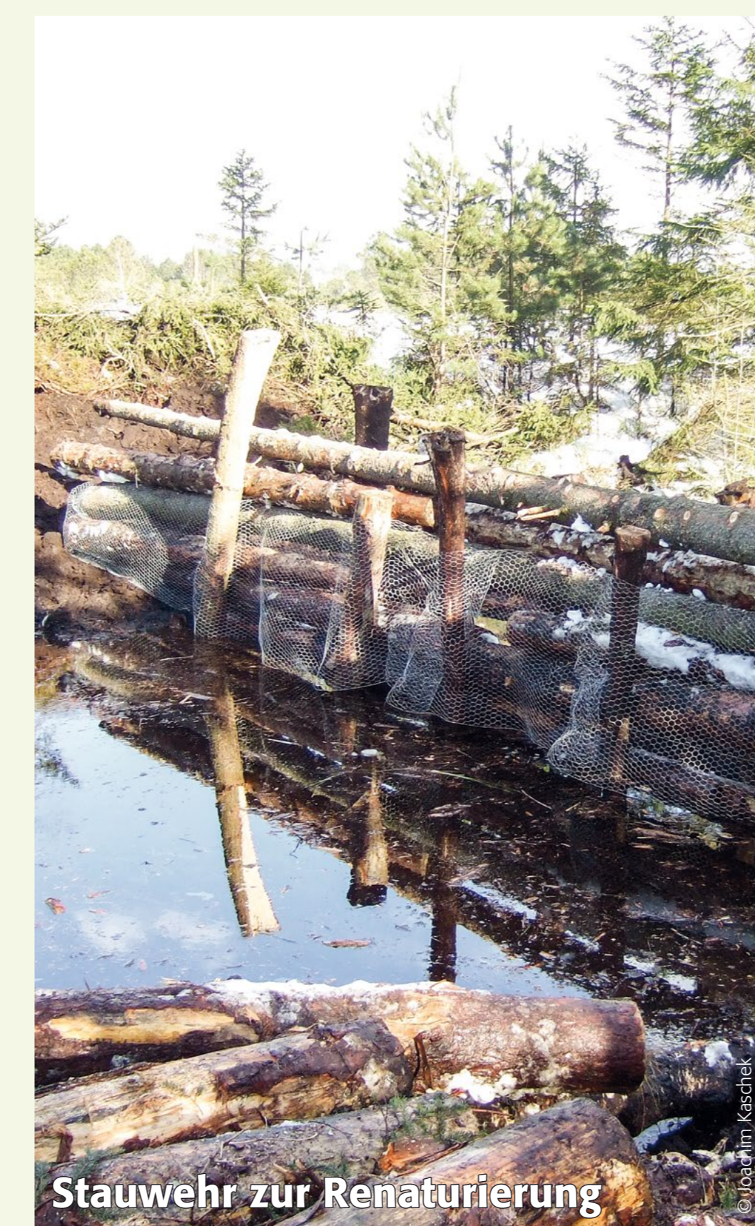
Stauwehr zur Renaturierung
